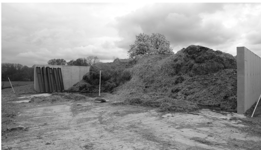
L'aire de stockage des fumiers n'est pas achevée. Elle sera prochainement couverte d'un toit.
