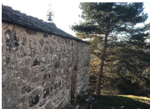
La « Capella St Stephanus », restaurée par l'association « Les Arts Verts » (chantier d'insertion) avec l'aide de Bruno Dépalle, le grand maître des lieux.
