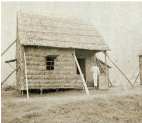
Yersin devant la hutte de bambou recouverte de paille de Hong Kong en 1894 où il découvrit le bacille de la peste. Collection de photographies de Yersin. © Institut Pasteur - Musée Pasteur.
